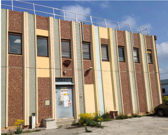
Figure 5 - Photo d'un répartiteur, vue extérieure
